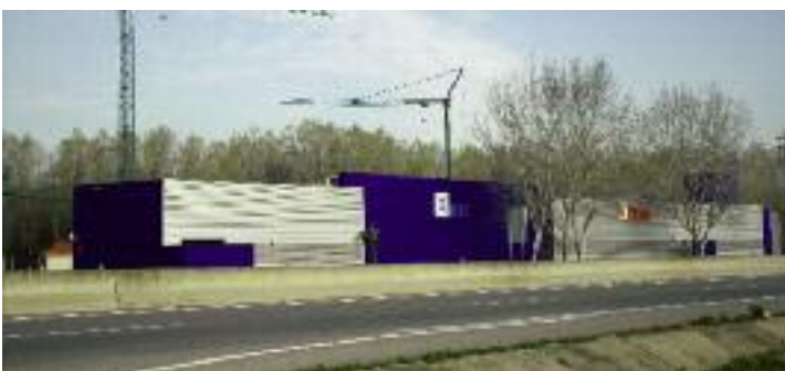
Estat actual de la façana del Centre de Formació de la UEC a Palol de Revardit, actuació dirigida pel Sr. Ricard Masó.
